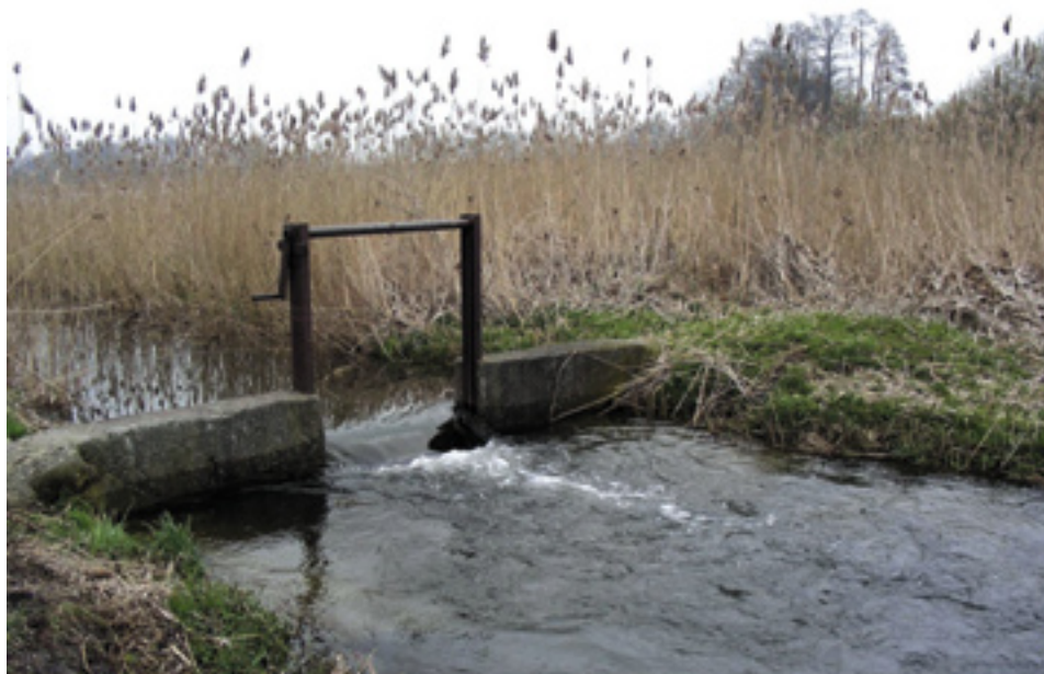
Ryc. 9. Urządzenie piętrzące na wypływie z jeziora Lednica – wysokie stany wody (fot. Bogumił Nowak)
