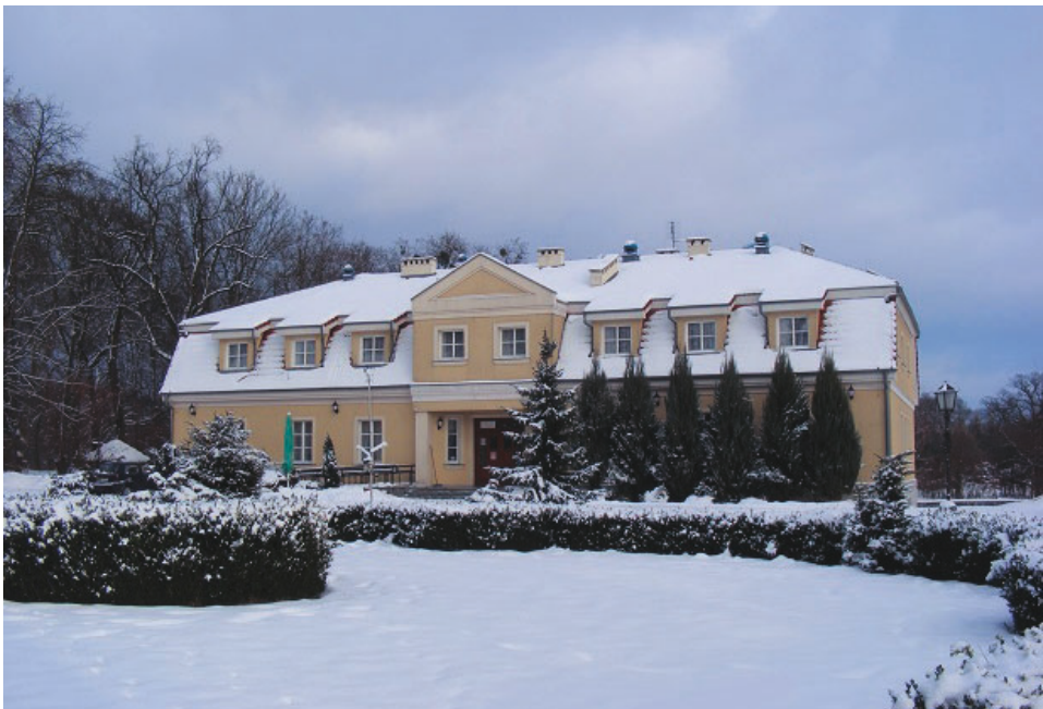
Fot. 2. Budynek bazy noclegowej (fot. K. Ferenc)
